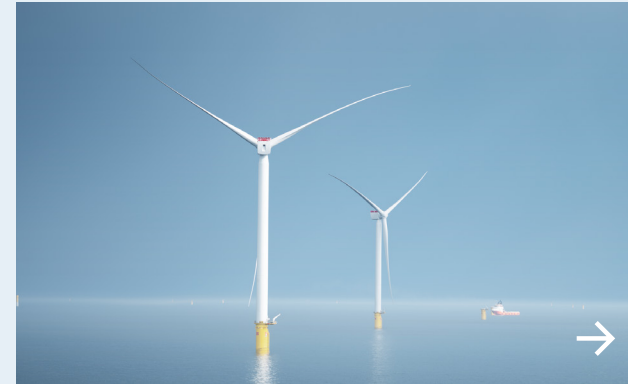
Opwekken van stroom
